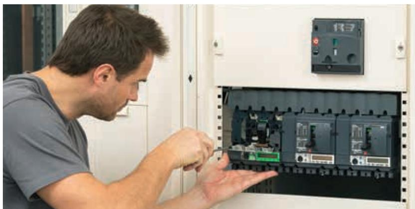
\* Der integrierte Differenzstromschutz in Compact NSX und NSXm wird ergänzt durch einen zusätzlichen Überlast- und Kurzschlusschutz.
